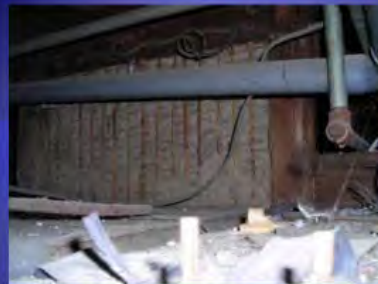
写真-1 土塗り壁(土台～2階梁まで)
