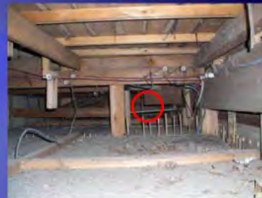
写真-2 土塗り壁(天井上に隙間あり)
