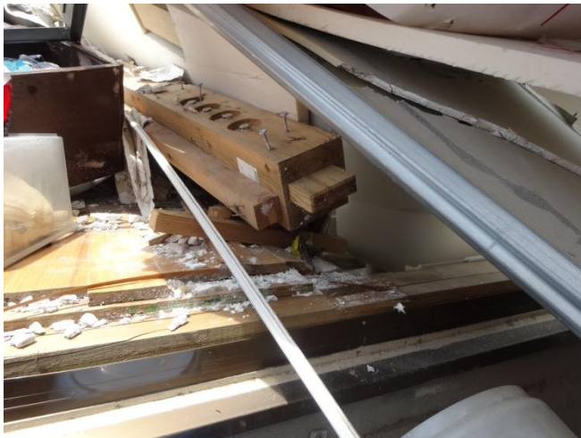
柱の引き抜きによる倒壊
