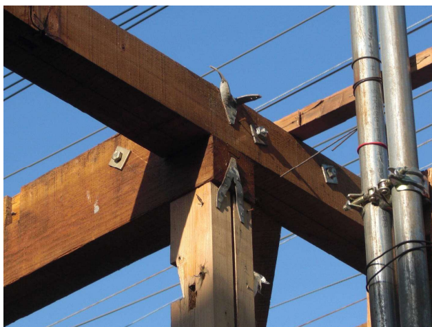
写真3 1階柱頭接合部
