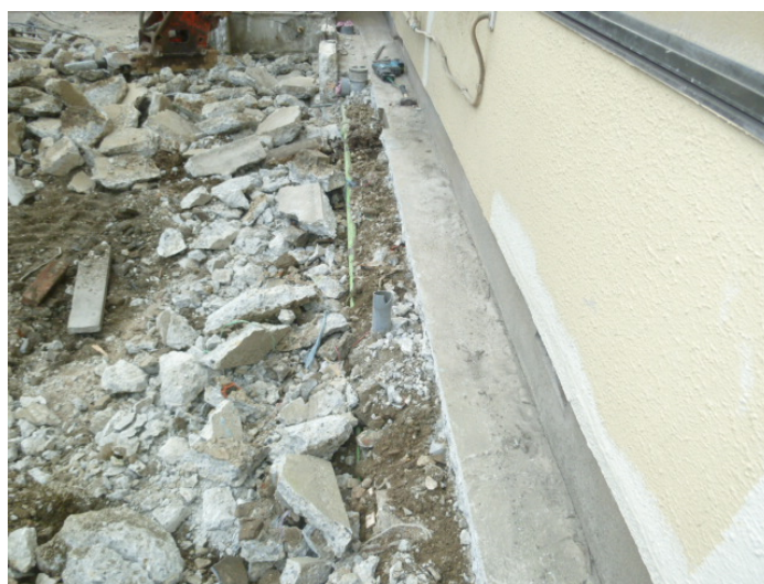
写真6 基礎(鉄筋コンクリートベタ基礎)
