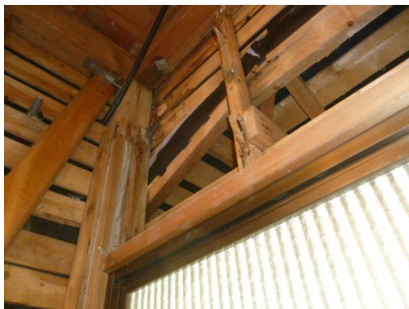
写真 7 外壁下地材(木ずり下地)
