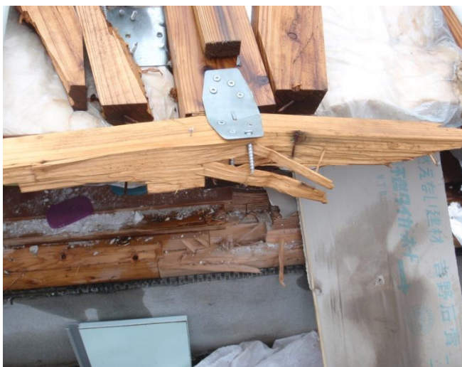
引き抜きによる土台の破断
