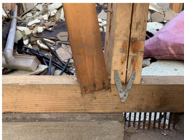
写真4 1階柱脚接合部
