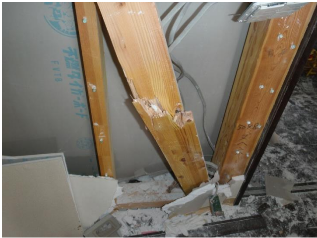
筋かいの圧縮破壊
